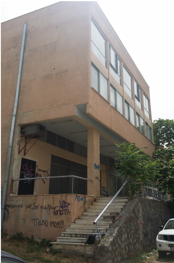
Υφιστάμενη κατάσταση – οδός Σοφοκλέους
