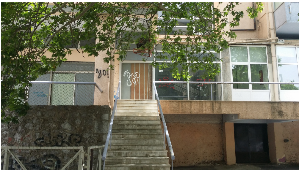
Υφιστάμενη κατάσταση – οδός Σοφοκλέους
