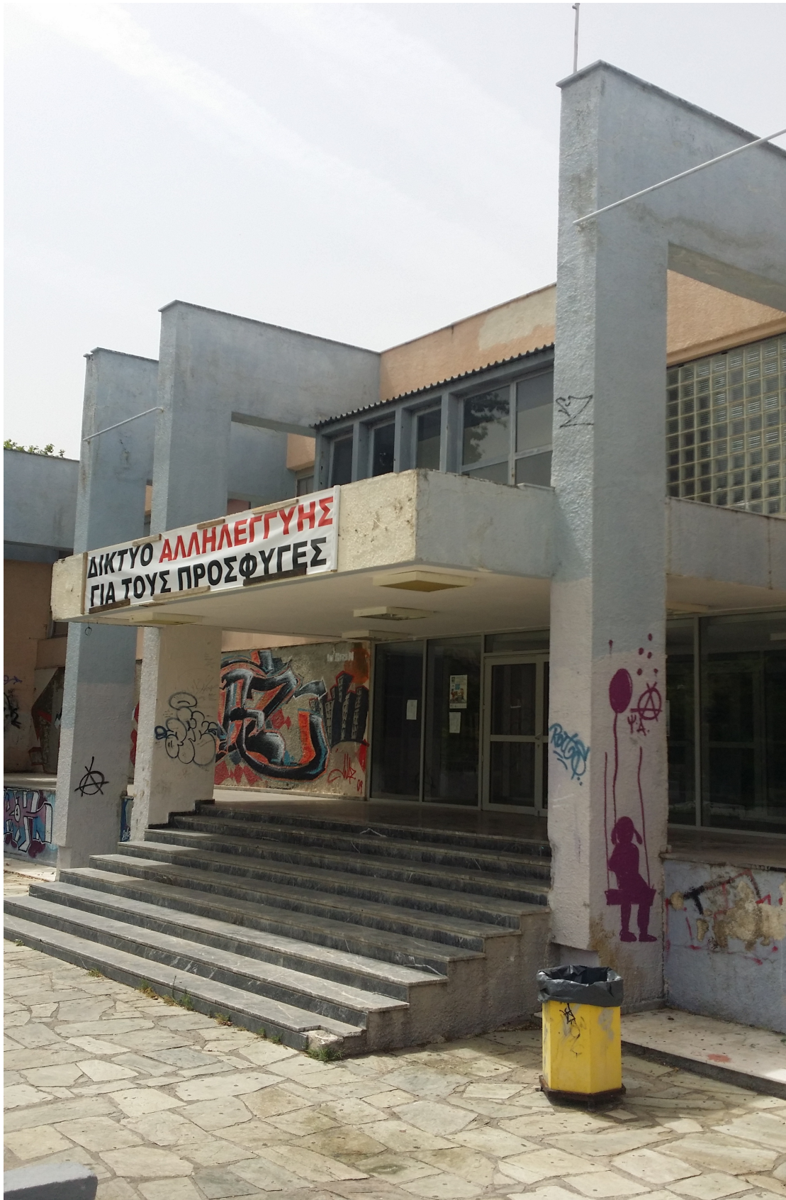
Υφιστάμενη κατάσταση – Είσοδος (Πλατεία Λάμπρου Κατσώνη)
